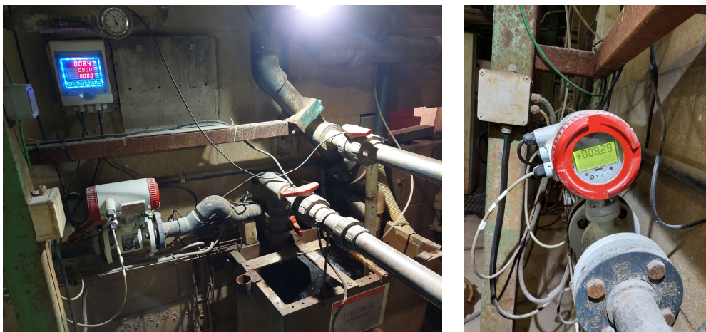
Figura 13 – Caudalímetro de vertido de las aguas industriales de Sidenor Legutiano
