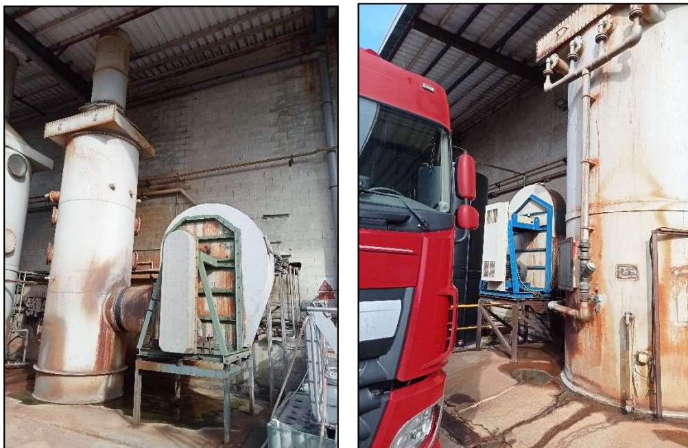
Figura 8.- Extracciones de gases vieja y nueva
