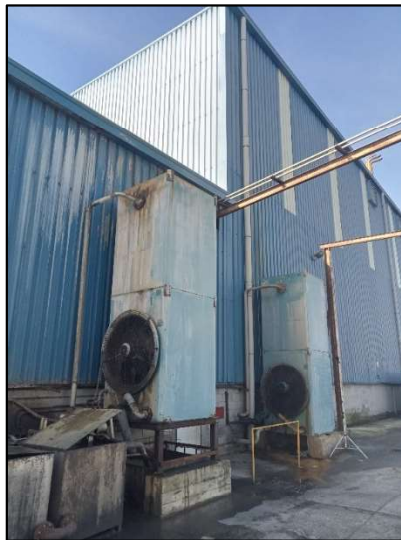
Figura 7.- Torre de refrigeración de hornos y máquinas
