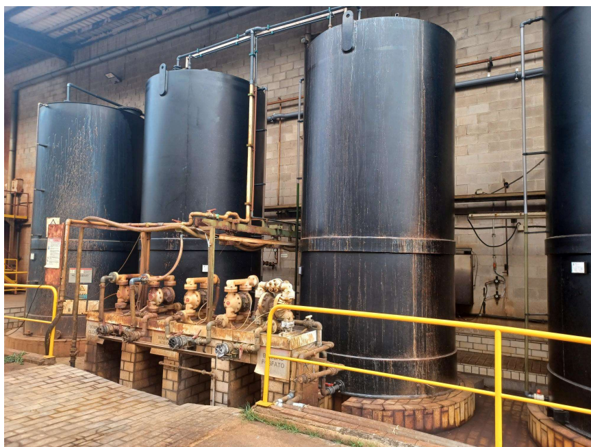
Figura 7 – Almacén exterior de Productos Químicos en cubeto
